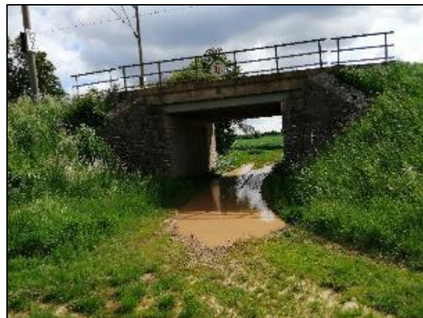
Abb. 4: Blick auf die EÜ Prosselsheim von Westen
