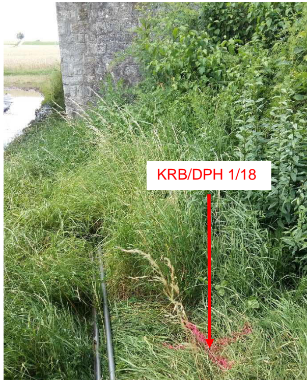
Bild 1 Lage der Aufschlusspunkte KRB/DPH 1/18, Blick nach Südwesten
