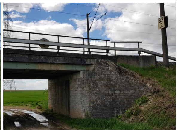
Blick Richtung Westen, - Bauwerk von der Ostseite
