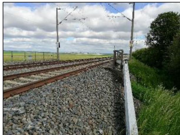
Abb. 6: Blick von Süden Richtung Norden über die EÜ
