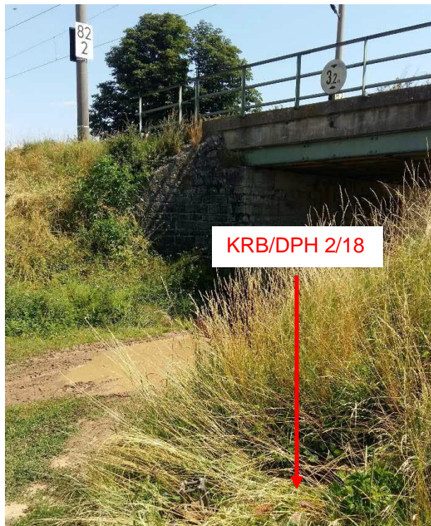
Bild 2 Lage der Aufschlusspunkte KRB/DPH 2/18, Blick nach Nordosten
