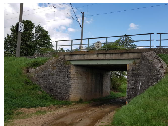
Blick Richtung Osten: - Bauwerk von der Westseite
