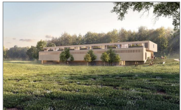
Derzeit im Bau: der neue Supermarkt in Würthsee mit Wohnungen im Obergeschoss © Quest Baukultur GmbH
