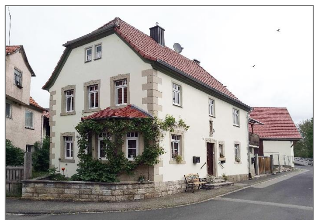
Das modernisierte Wohnhaus in Oberstreu. Foto: ALE
