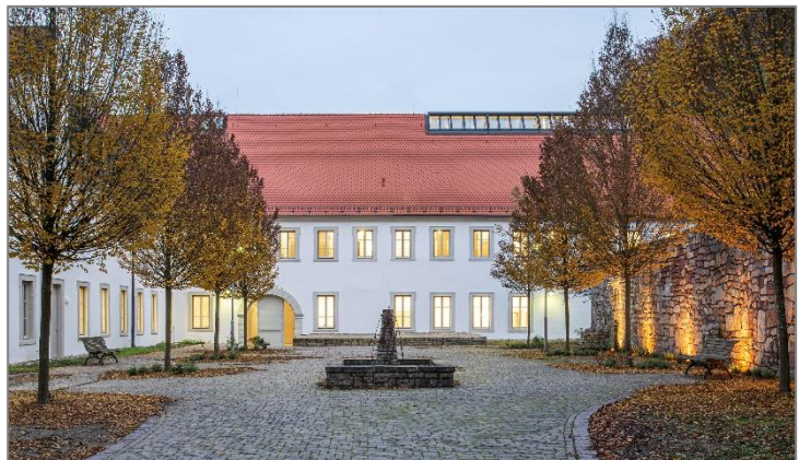
Oben: Ehemaliger Bestand vor dem Umbau. Unten: Heutiger Innenhof. Fotos: Brückner & Brückner Architekten (oben); mju-fotografie, Marie Luisa Jünger, Hümpfershausen (unten)
