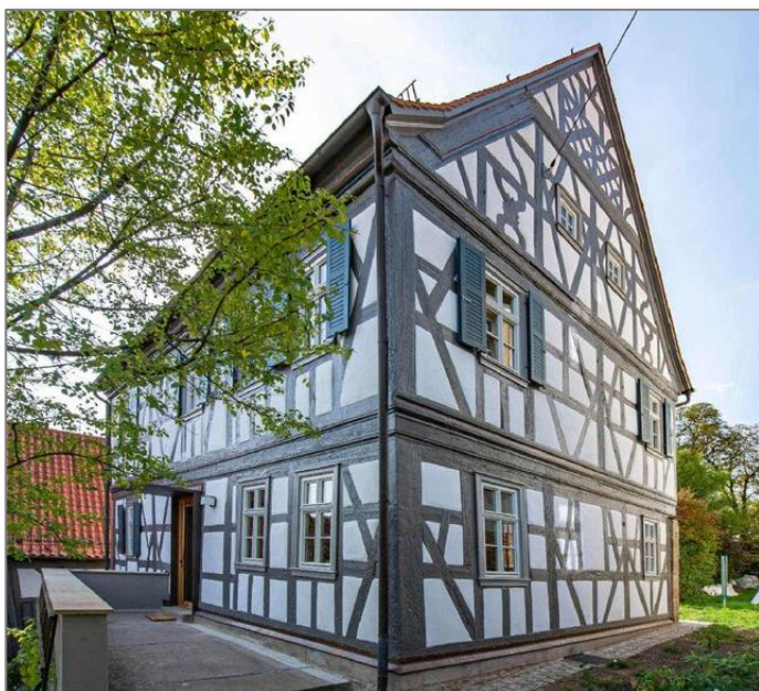
Fachwerkhhaus in Birnfeld, rechts vor der Sanierung und links danach.
