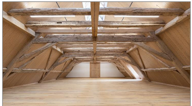
Beachtlicher Vorher-Nachher-Vergleich: Umbau des alten Dachstuhls zu einem Proberaum. | Fotos: Brückner & Brückner Architekten (oben); mju-fotografie, Marie Luisa Jünger, Hümpfershausen (unten)
