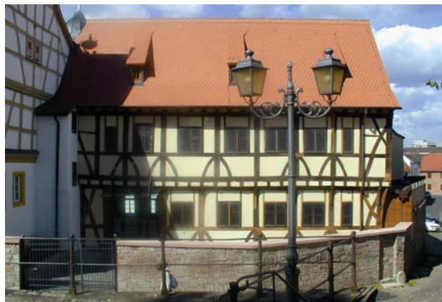
Gotisches Haus nach der Sanierung
