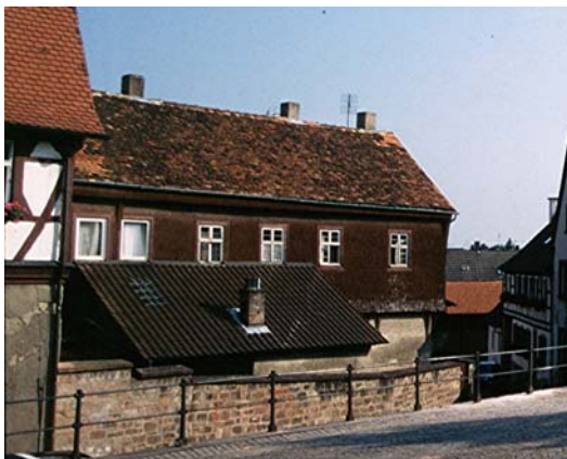
Zustand vor der Sanierung
