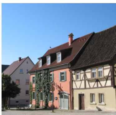
Sanierung Alte Schule vorher
