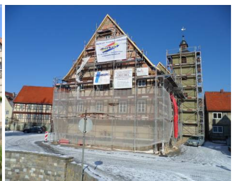
während der Bauphase © Gemeinde Nordheim v.d.R.
