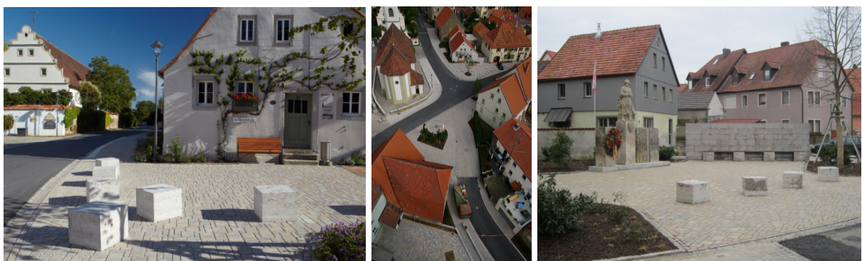
Neugestaltung Ortsmitte Fotos nach der Fertigstellung
