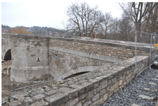
Fotos während der Baumaßnahme
