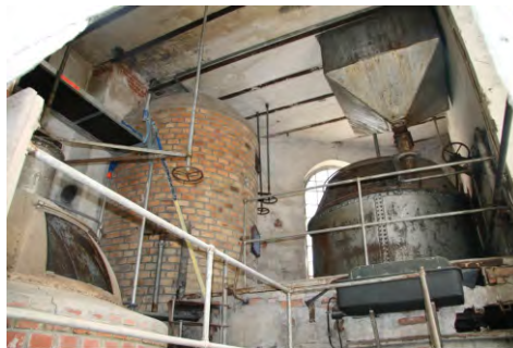
ehem. Brauerei vor Sanierungsbeginn
