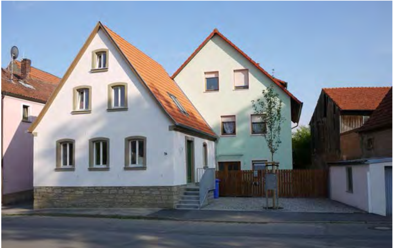
... und nach der Sanierung von außen...
