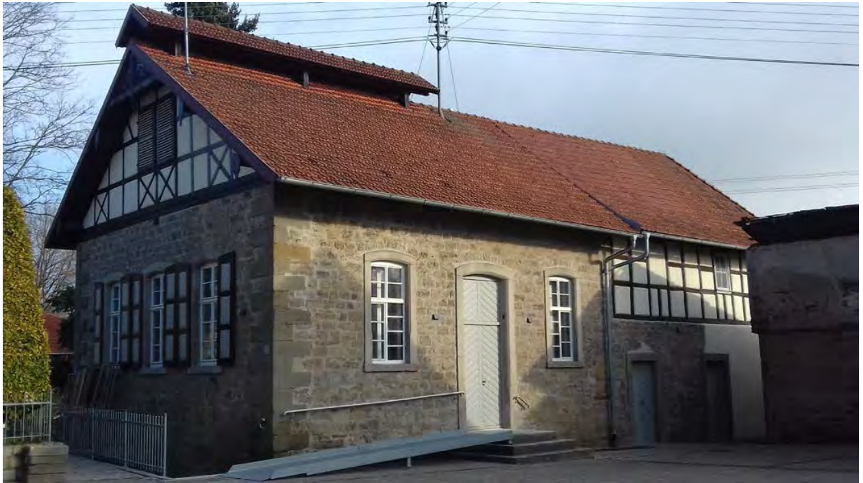
Nach der Sanierung © Gemeinde-Allianz „Hofheimer Land e.V.“
