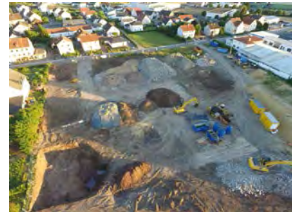
Nach dem Abbruch Fotos © Gemeinde Salz
