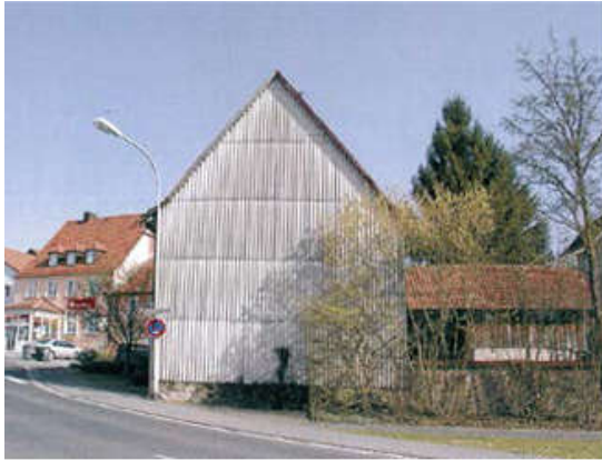
Straßenansicht mit Eternitverkleidung vor...
