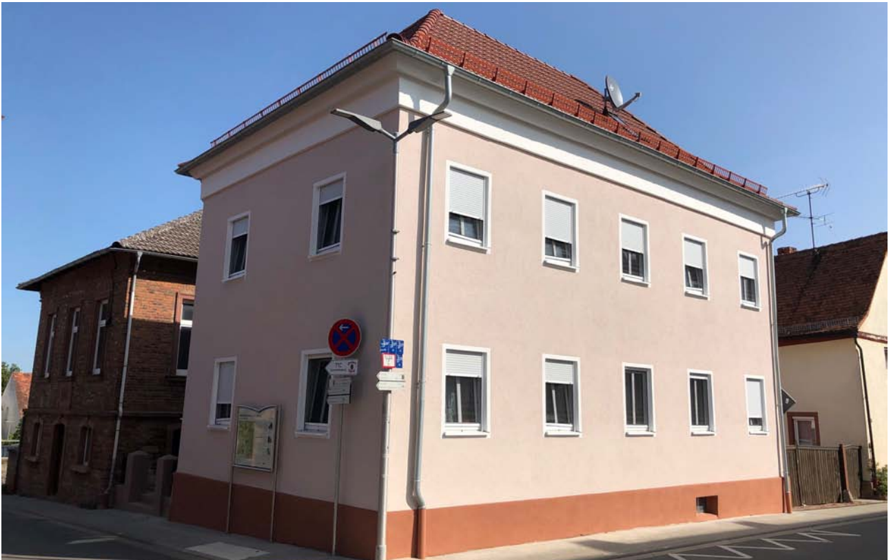
Altes Rathaus nach der Sanierung
