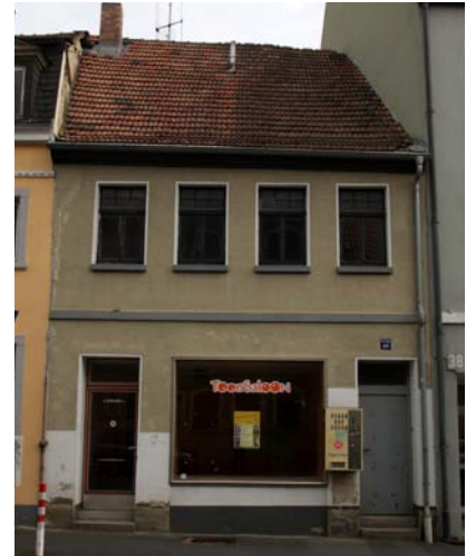
Hofansicht vor der Sanierung Foto © Stadt Schweinfurt
