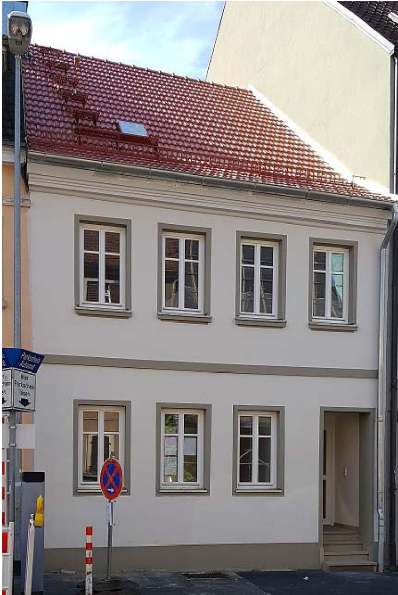
Ansicht nach der Sanierung Foto © Stadt Schweinfurt
