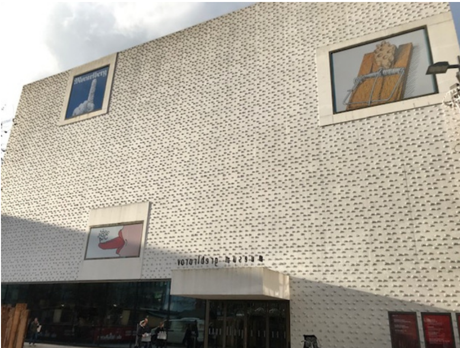
Abb. 1: Fassade des vorarlberg museums. Foto: Reinhold Luger.
