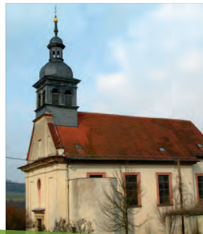
< St. Ägidius in Holzkirchhausen vor der Sanierung
