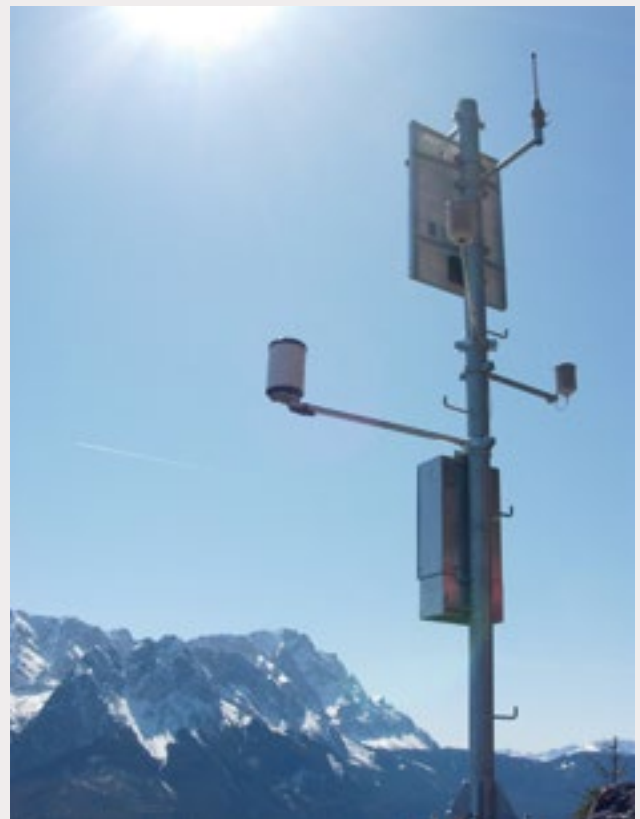
Abbildung 1: Eine von vier neu installierten Klimastationen
