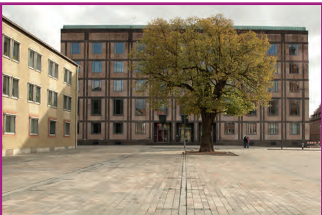
Der sanierte Peterplatz 2011, Foto: Staatliches Bauamt Würzburg
