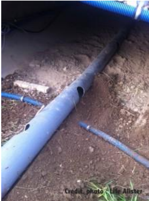
Abbildung 5: Beispiel für eine Prädationsschutzröhre in einem Wildtierdurchlass, wie sie im französischen LIFE-Projekt ALISTER im Rahmen von wissenschaftlichen Versuchen entwickelt und getestet wurde (ALISTER 2016).
