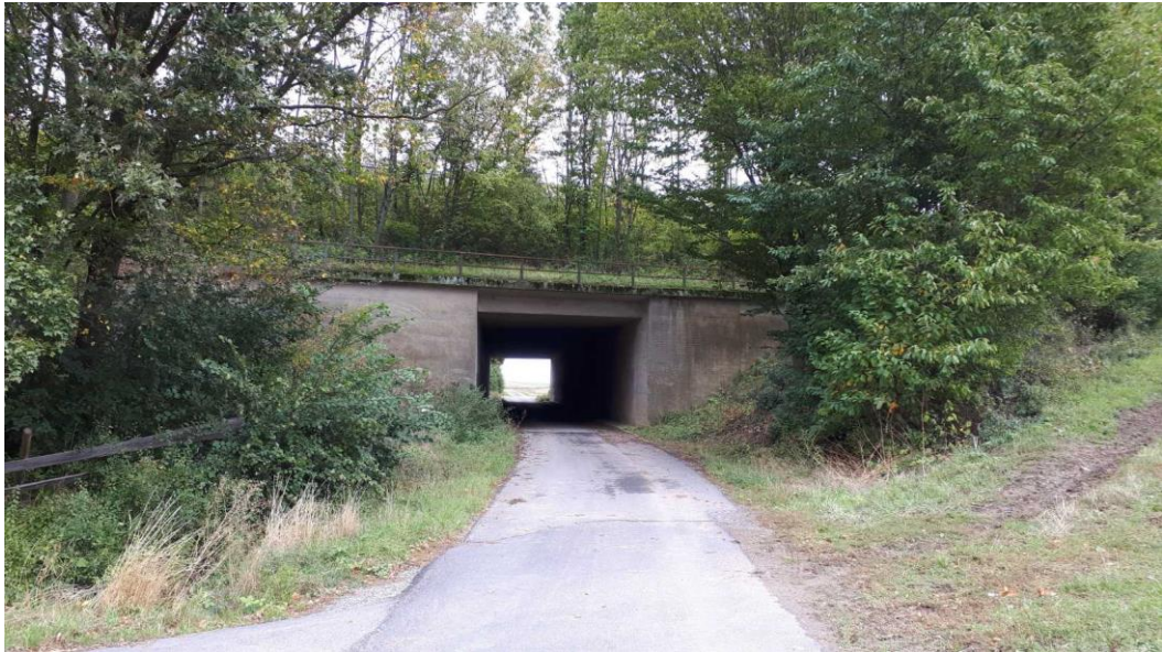
Abbildung 4: Brückenbauwerk 665b mit Leitfunktion, beidseitig und oberhalb Licht abschirmende Gehölze (Foto: A. Schuster, 05.10.2019)
