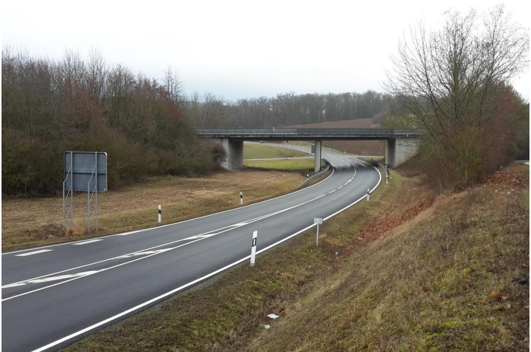
Abb. 14: Brücke über die St 2277 von Süden betrachtet.
