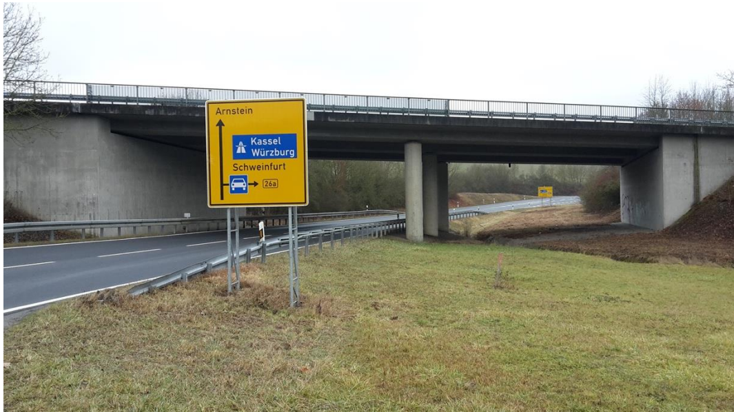
Abb. 13: Bestehendes zweifedriges Brückenbauwerk über die St 2277 von Norden betrachtet.
