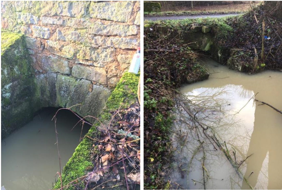
Abb. 42: Durchlass Mühlbach, Ansicht Richtung Süd bzw. Nord
