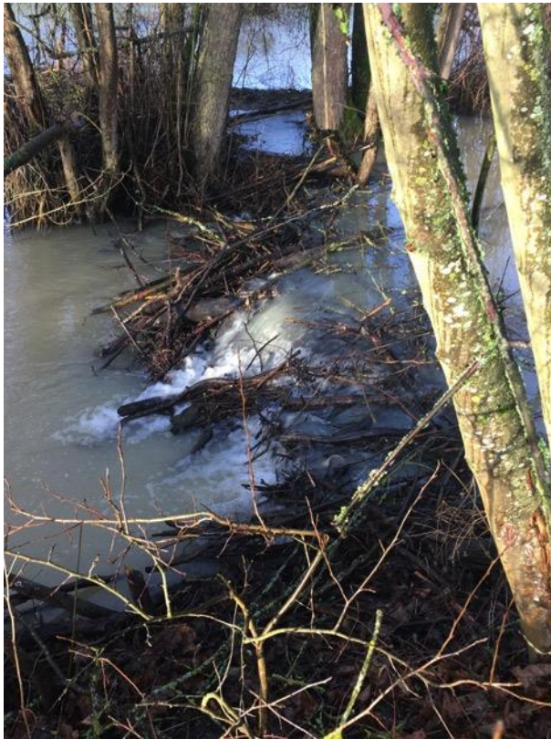
Abb. 57: Dammbauwerk des Bibers unterhalb des Krebsbachdurchlasses
