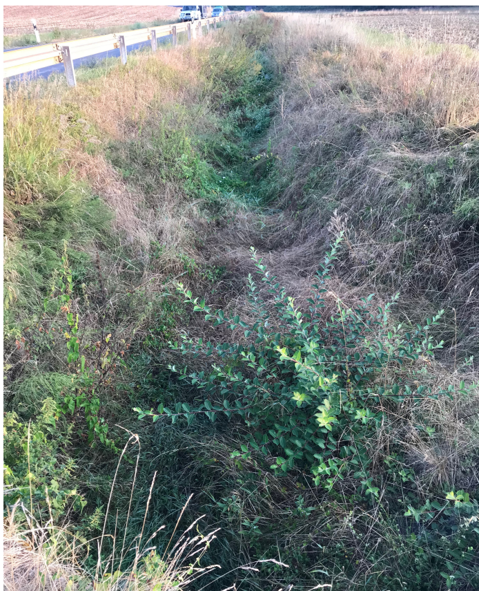
Abb. 4: Ziegelbach, Erfassung (August 2018), Blick Richtung Norden
