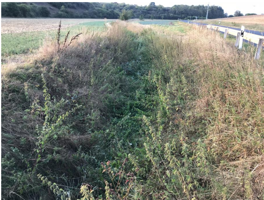
Abb. 3: Ziegelbach, Erfassung (August 2018), Blick Richtung Süden
