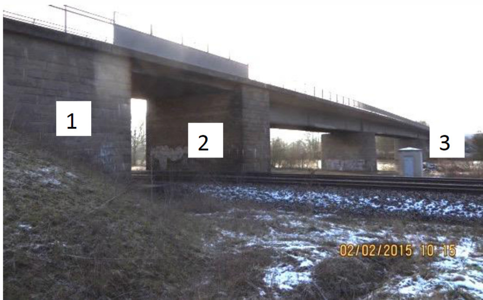
Abbildung 1: Übersicht zu drei untersuchten Brückenbauwerken an der Mainbrücke bei Horhausen
