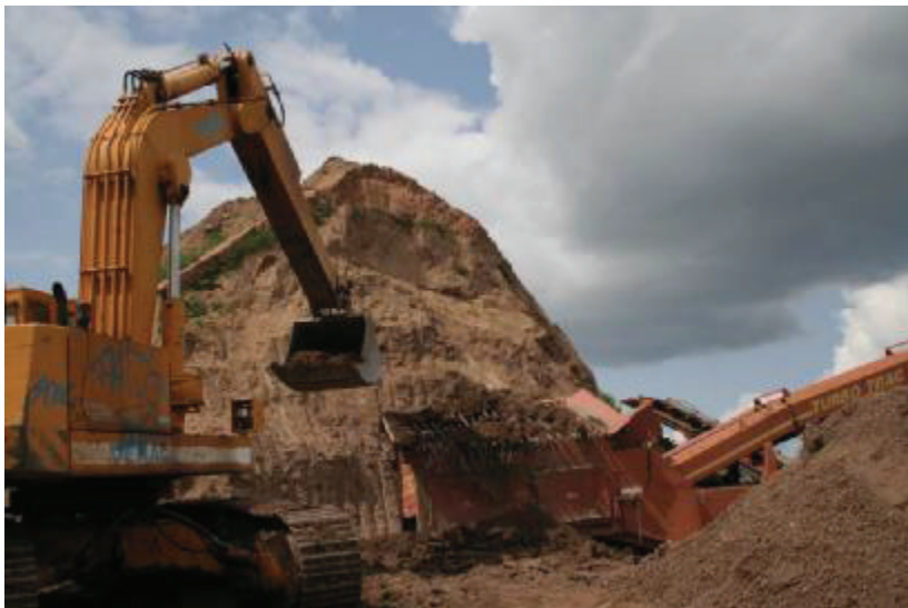
Foto 8: Der obere Bereich der Rutschung einer Erddeponie in der Kiesgrube Volz wird seit 2010 von Uferschwalben besiedelt.
