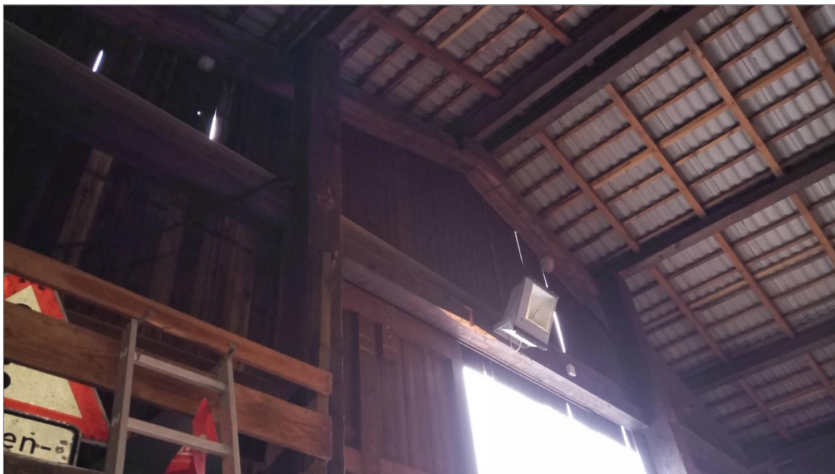
Abbildung 2: Eingangsbereich / Dach Salzlagerhalle
