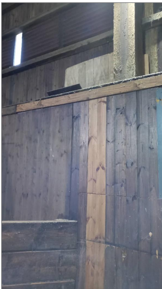
Abbildung 3: Holzverkleidung der Wände im Innenbereich der Halle
