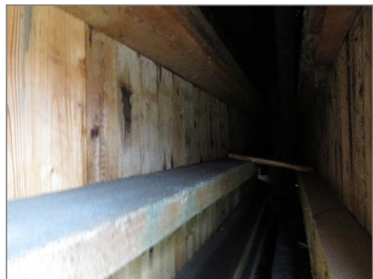
Abb. 5: Innenansicht der doppelten Verschalung des Gebäudes
