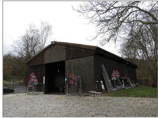
Abb. 3: Teilansicht der Nordost- sowie Südostseite des Gebäudes
