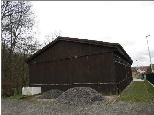
Abbildung 2: Teilansicht der Nordwest- sowie Südwestseite des Gebäudes
