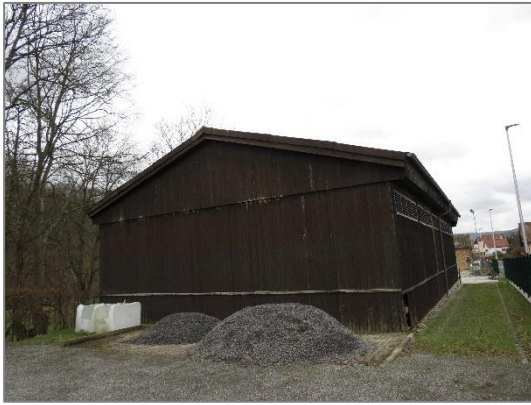
Abb. 2: Teilansicht der Nordwest- sowie Südwestseite des Gebäudes
