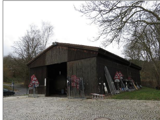
Abbildung 3: Teilansicht der Nordost- sowie Südostseite des Gebäudes
