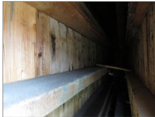
Abbildung 5: Innenansicht der doppelten Verschalung des Gebäudes
