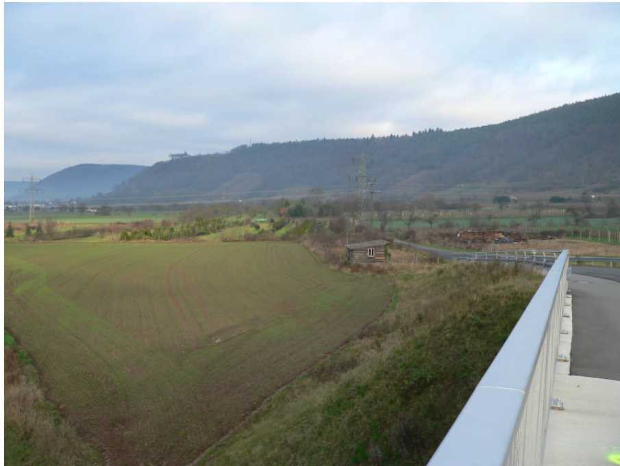
Blick nach Norden, Bereich des nördlichen Kreisels
