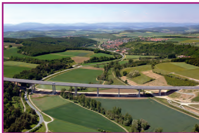
Saaletalbrücke Foto: Hajo Dietz, Nürnberg Luftbild
