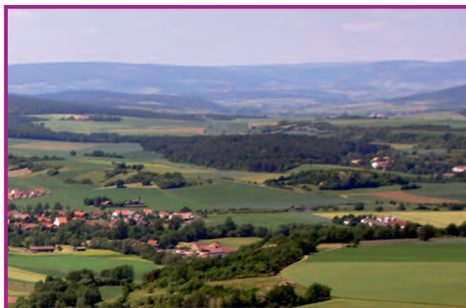
Bahratalbrücke Foto: Hajo Dietz, Nürnberg Luftbild
